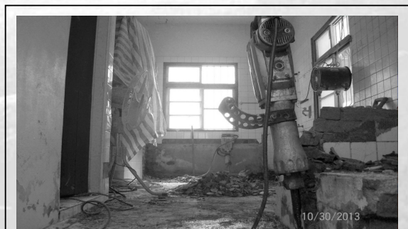
花蓮營地施工 Construction in Hualien Center
