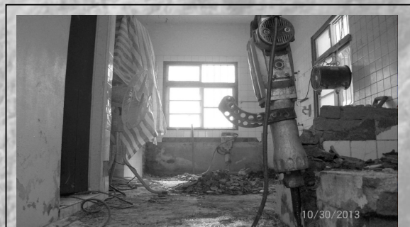
花蓮營地施工
